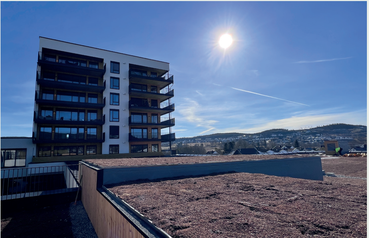
Store deler av taket er bygget som takhager, samt at deler av taket er beplantet med sedum.
