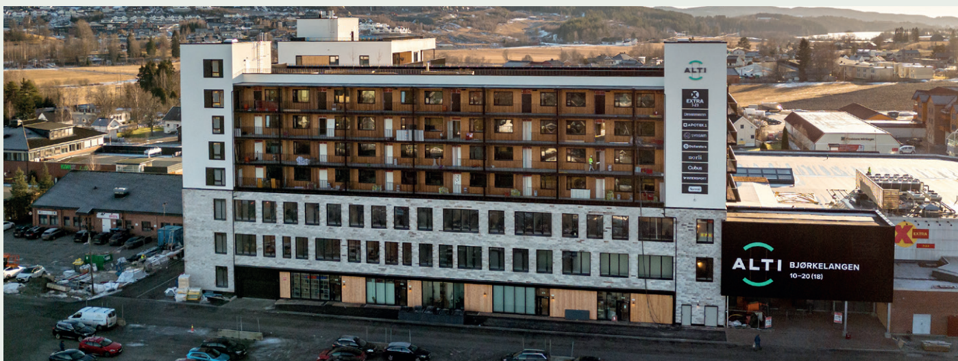
STØ Entreprenør har nå overlevert kjøpesenteret ALTI Bjørkelangen Nord og boligprosjektet Torgalléen.
